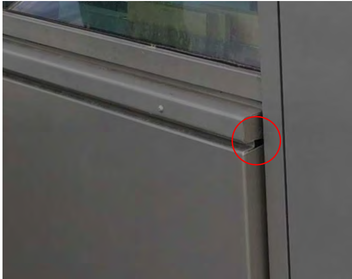
Mynd 24: "loftræstiop" í efri brún áklæðningar
