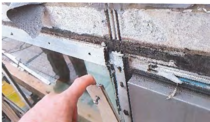
Öndunardúkur undir áklæðningu á austurhlið hússins
