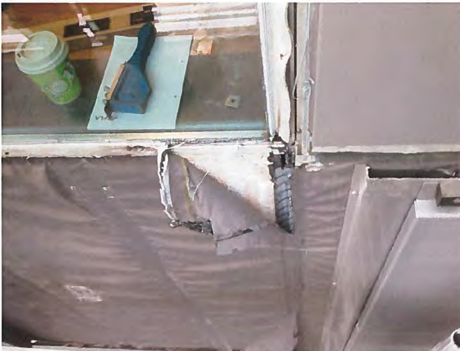
Mynd 13: Á austurhlið hússins er klætt yfir sementsbundnar trefjaplötur (VIROC) með vatnsheldum öndunardúk. Gluggafölsur er lokað að utan með þéttiborðum og þar yfir koma glerlistar sem halda plötum og gleri föstum í falsi gluggakerfisins. Áklæðing er fest utan á plötur í gluggakerfinu auk þess sem állistar pressar hana fasta. Búið er að kítta í gluggaföls utan með plötum. Frágangur er með þeim hætti að vatn kemst inn í gluggaföls en ekki er augljós drenun út úr gluggakerfinu nema undan gleri. Auk þess má sjá að drenrásir eru víða stíflaðar með kíttri.
