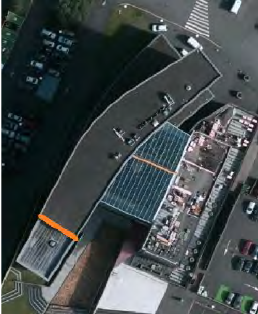
Mynd 5: Veggur við svalir 6. hæðar.
