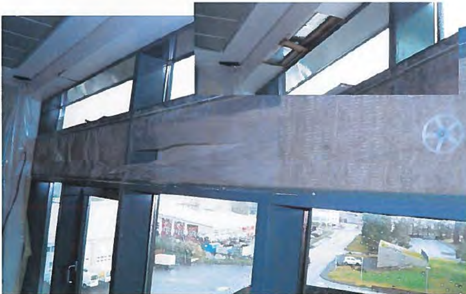
Mynd 22: Sjá má ummerki um leka innanhúss á móts við skoðunarstað utanhúss á 3. hæð. Klæðning í lofti sem gengur út að gluggum er rakaskemmd og mygla í trégrind þar fyrir innan. Rekja má leka til frágangs á VIROC plötum (stuttar) og einnig eru gúmmiþéttingar í gluggafölsum þunnar og dekkja mögulega ekki hrjúfleika platnanna. Rakasperra innan á gluggakerfi var nokkuð vel frá gengin en þó mátti sjá loftlekaleiðir á milli gluggaeininga. Ekki er heldur hægt að ætla að VIROC plötur séu loftþéttar vegna opinna skrúfugata, skemmda og rifa í plötum og það getur valdið rakapéttingu inni í gluggakerfinu.
