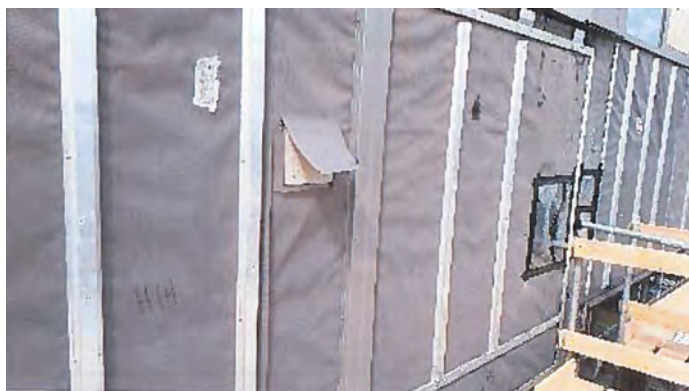
Öndunardúkur undir áklæðningu á austurhlið hússins
