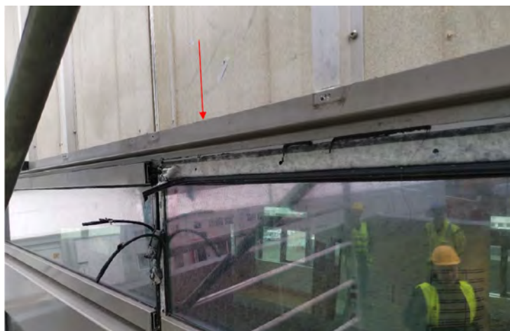
Mynd 23: Flösking framman gluggaprófil leiðir vatnið af Conchip plötum að þéttilista á bakhlið flöskingar.
